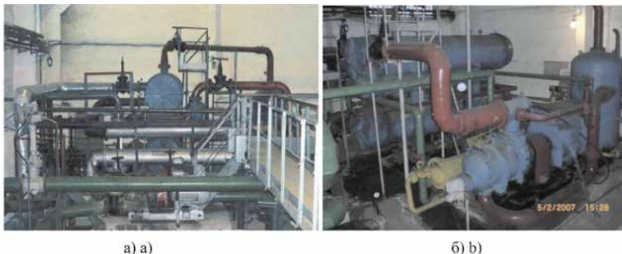
Рисунок 5а и б. Промышленный тепловой насос НТ-3000 на АО «Казцинк»
