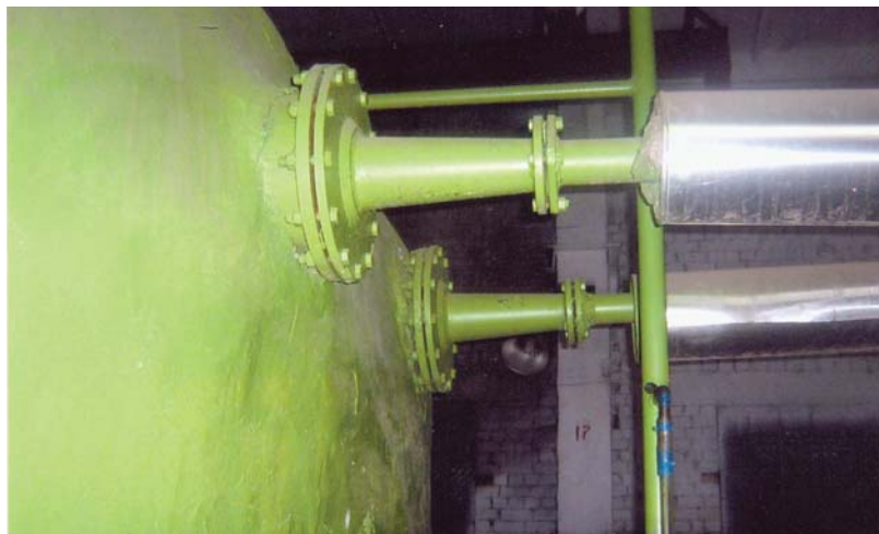
Рис. 1. Кавитационно-разгонные устройства бака-аккумулятора деаэрата DCA-200.
